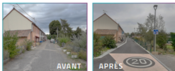
Travaux à Wolfersdorf (68) | Crédit photo : Territoire d'Énergie Alsace
