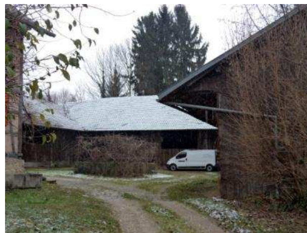
N° 10 – XXe siècle Ferme-cour, plan-type en U conservé, bâtiments agricoles reconstruits Toiture tuiles mécaniques. Prescriptions : Ensemble très en retrait de la rue, bâtiments agricoles bas et de peu d'impact, conservation de la maison plus importante.
