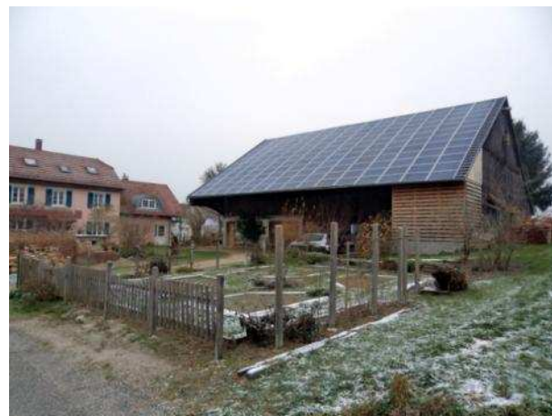
N° 15 – XIXe - XXe siècle Ferme-cour disposée en L. L'importante grange-étable est assez éloignée de la maison, et sa couverture porte des panneaux photovoltaïques en versant Sud-Ouest. Prescriptions : non. Ensemble en bon état.
