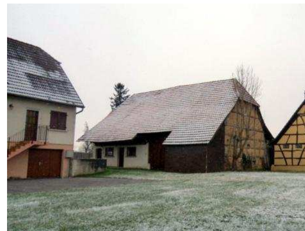
N° 4 – XVIIIe (?) – XXème siècles Ancienne ferme-cour disposée en L. Maison reconstruite dans les années 1970 ou 80, mais bâtiment agricole du XVIIIe ou début XIXe bien conservé. Intéressant dialogue de son pignon avec celui de la grange du 16, rue Principale. Prescriptions : Conservation volumes et avant-toits de l'ancienne grange-étable, avec colombages apparens.
