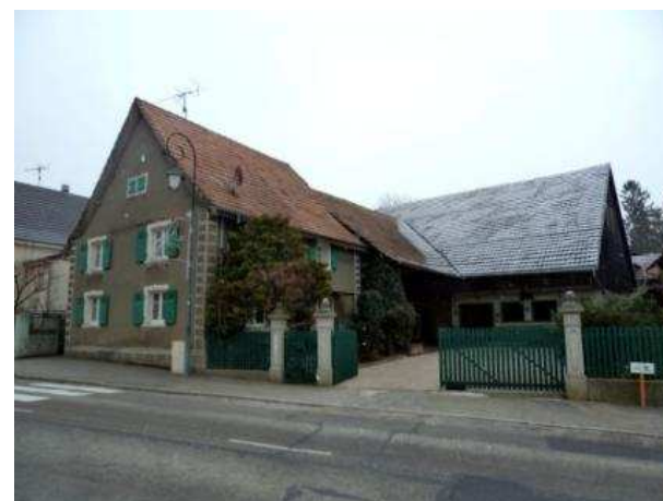
N° 14 – XVIIIe - XXème siècle Ferme-cour à groupement en L, peut-être à l'origine une ferme-bloc. Partie en équerre vraisemblablement tardive, mais volume intéressant. Prescriptions : Restitution des colombages enduits (maison), conservation des volumes et avant-toits.
